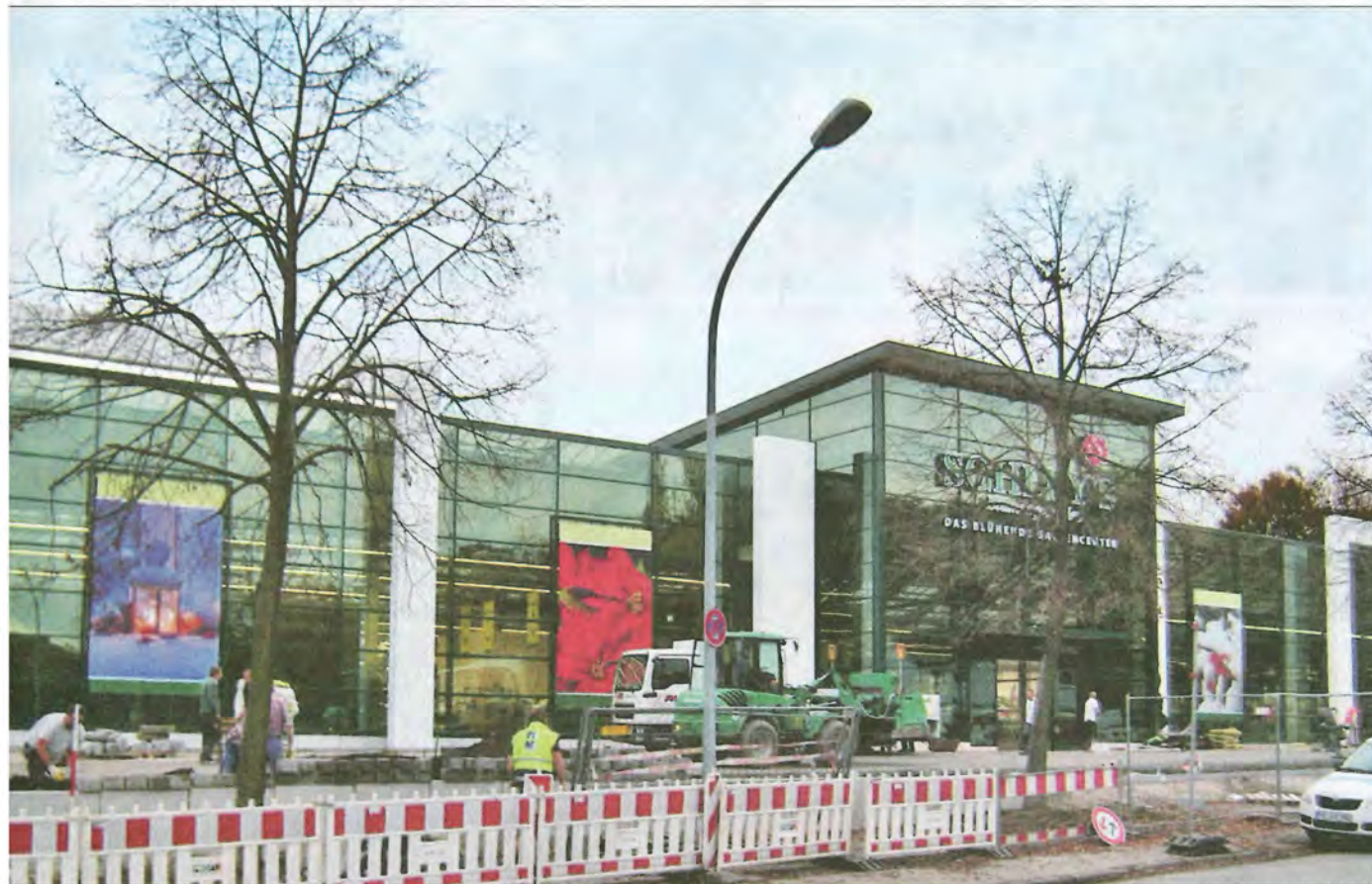
Schley Gelsenkirchen: Moderne Beton-Arkaden an der Fassade. Zum Einsatz kam erstmalig das VarioPlus Klima-Aktiv-Haus (Kräss). /SCHEFFLER
