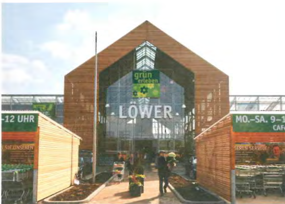
Wegen seiner Ähnlichkeit mit einem Scheunentor weckt das 17 m hohe Eingangsportal die Landlust.
